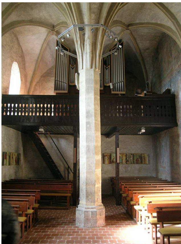
2. osemstranný nosič svietidiel (zatiaľ bez nárožníkov),
