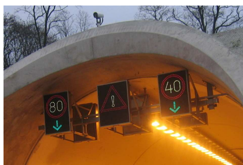
Obr. 7 Umístění PDZ LED na vjezdu do tunelu, technologické zkoušky
