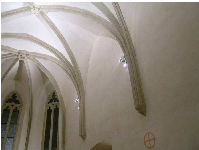
1a. umiestnenie svietidiel „za“ gotickými rebrami
